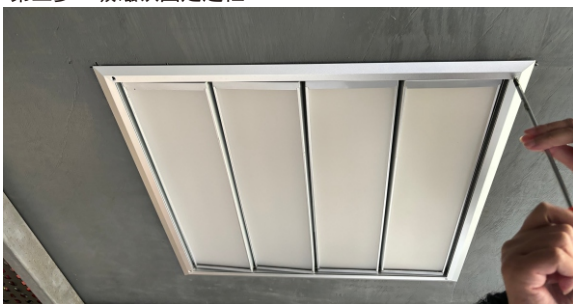
第四步：用4颗M4X16沉头螺丝锁紧即完成安装
