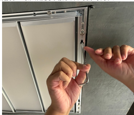
第二步：通过调节灯具外框所有的黑色内六角螺丝来调整灯具高度(上图所示). 直到灯具高度完全与天花板高度持平即可
