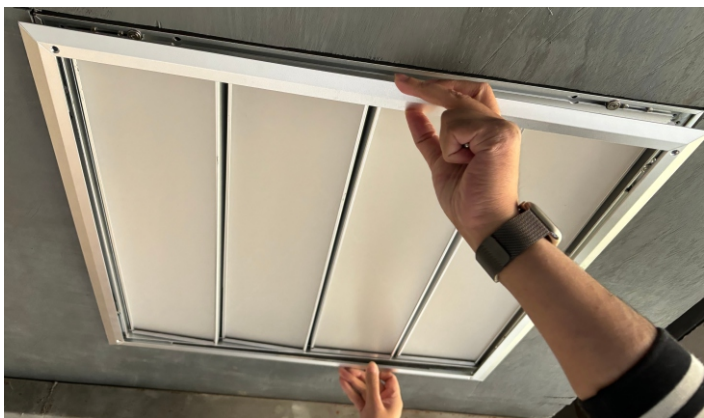
第三步：吸磁铁固定边框
